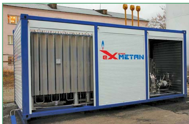
Фото 2. Блок газификации СПГ, оборудованный атмосферным испарителем и криогенным плунжерным насосом высокого давления
