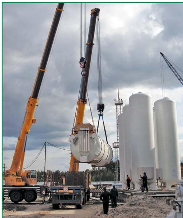
*Фото 8. Монтаж криогенных резервуаров*
