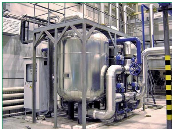
**Фото 5.** Блок очистки и осушки воздуха установки
