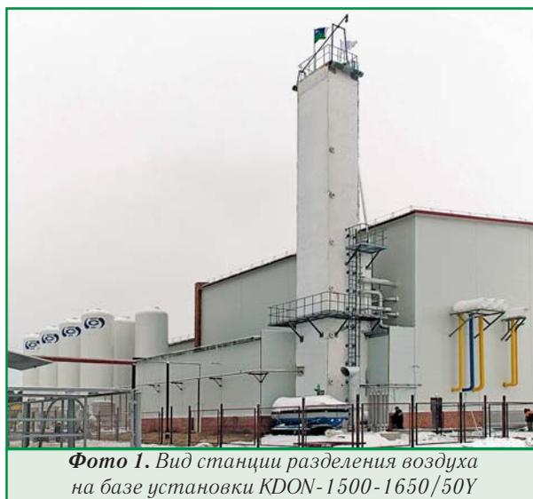
Фото 1. Вид станции разделения воздуха на базе установки KDON-1500-1650/50Y
