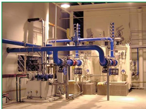
**Фото 6.** Турбодетандер-компрессорный агрегат (рабочий и резервный)
