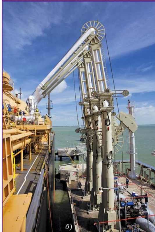
Фото 16. Внешний вид причала приёмного терминала СПГ (а) и погрузочная / разгрузочная система СПГ (б) с СПГ-рукавами: три рукава для жидкого СПГ, один — для возврата паров, образующихся при вскипании СПГ
