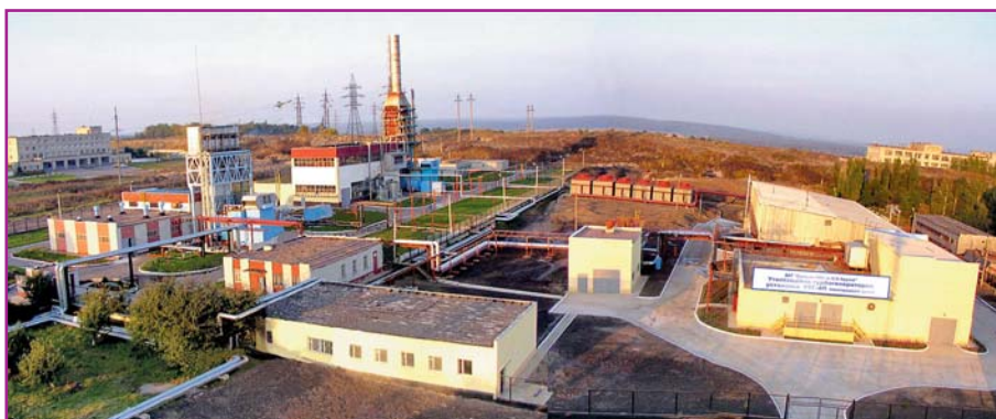
Фото 3. Энергокомплекс ОАО «Сумское НПО им. М.В. Фрунзе» мощностью 40 МВт
