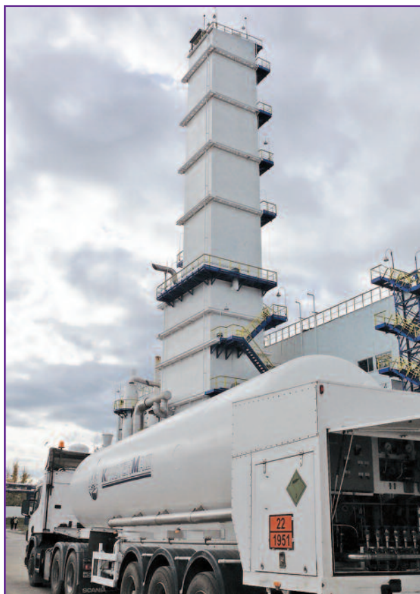
Фото 1. Вид на новый цех разделения воздуха Северского трубного завода (РФ) с современной крупнотоннажной ВРУ КдАдАр-9/3 производства ОАО «Криогенмаш»
