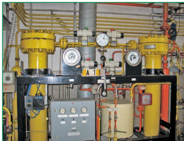
**Фото 7.** Установка осушки ацетилена обратным потоком
