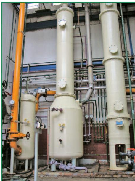
**Фото 6.** Технологическое оборудование для химической очистки ацетилена
