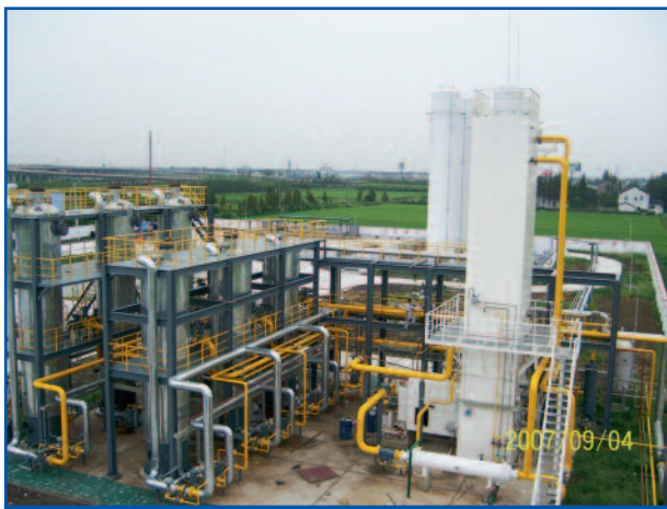
Фото 2. СПГ-установка с использованием перепада давлений на ГРС
