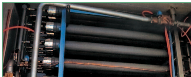
Фото 3. Мембранный газоразделительный блок станции
