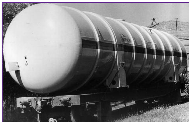
Фото 8. Ёмкость-хранилище жидкого кислорода системы заправки 11Г722
