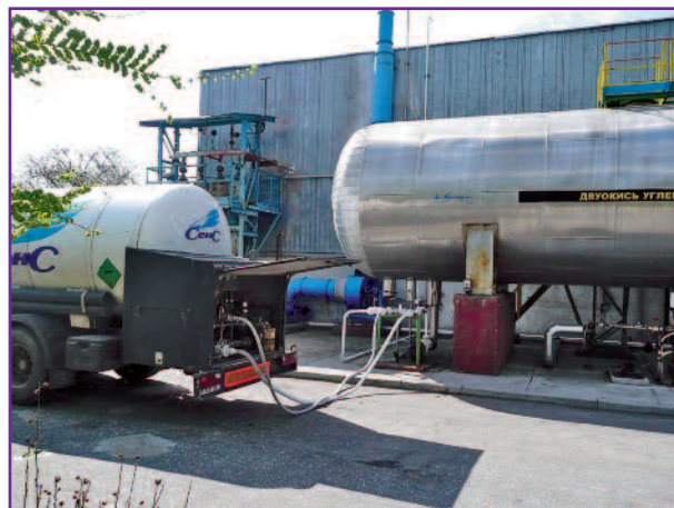
Фото 13. Цистерна для хранения 100 м 3 жидкого низкотемпературного CO 2 на территории ОАО «Одесский припортовый завод»
