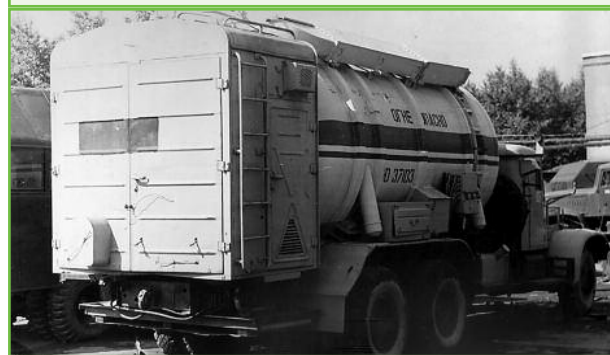
Фото 7. Общий вид автомобильного заправщика-газификатора жидкого водорода
