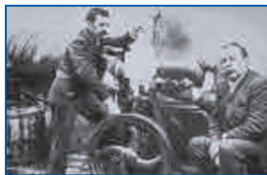
Фото 3. Жорж Клод (слева) демонстрирует Полю Делорму детандер, созданный для работы в составе ожижителя воздуха. В дальнейшем детандеры использовались во всех криогенных ВРУ
