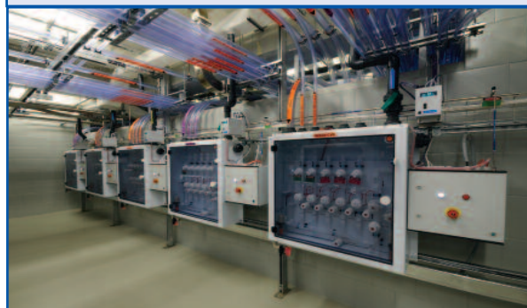
Фото 8. Узел распределения жидких реагентов, состоящий из шкафов, содержащих пневматические и ручные вентили подачи веществ в производство предприятия «НИИМЭ и Микрон»
