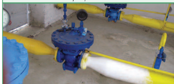
Рис. 2. Обмерзание трубопровода после дросселя
