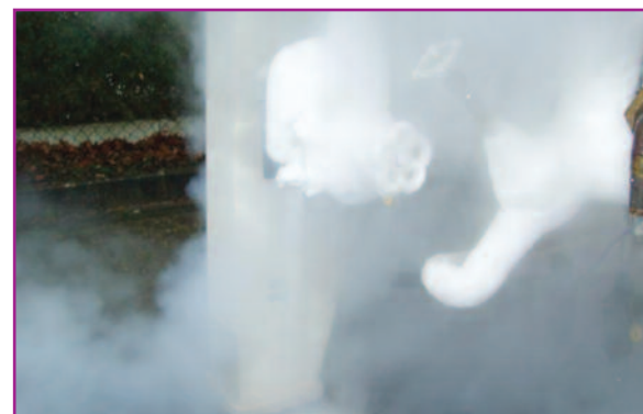
Фото 6. Обледенение и срабатывание клапана
