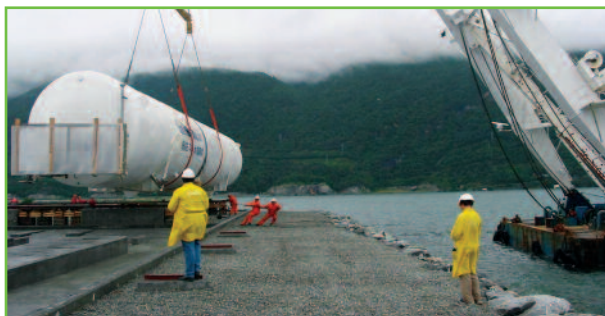
Фото 5. Установка вакуумно-изолированной ёмкости объёмом 500 м 3
