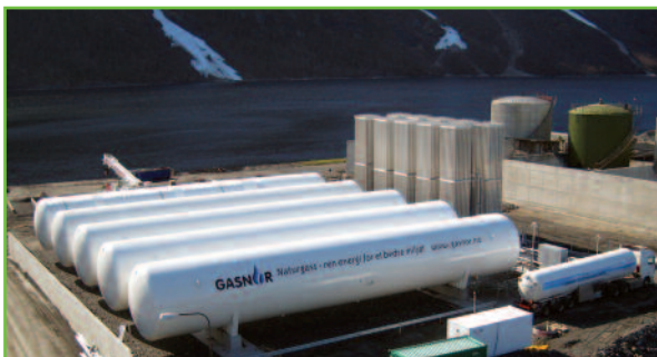
Фото 10. Спутниковая станция Mosjoen в северной Норвегии (поставка 2007 года) с общим объемом хранения 3415 м 3 (5 × НТ683)
