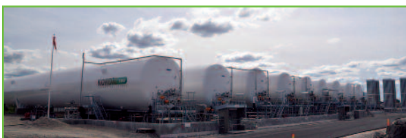
Рис. 11. Комплекс для промежуточного хранения, дистрибуции и заправки судов СПГ (Oera, Норвегия) с общим объемом 6400 м 3 , состоящий из резервуаров: 2×НТ1000, 5×НТ683, 2×НТ500 (поставка 2011 года)
