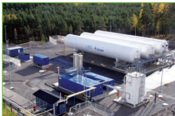
Фото 13. Ожижитель компании Gasum в Финляндии с тремя резервуарами «Chart Ferroх» с объёмами по 683 м 3 каждый
