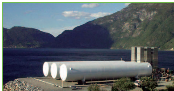
Фото 7. Три горизонтальные вакуумно-изолированные ёмкости HT500/8 (500 м 3 /8 бар) для спутниковой станции СПГ 1500 м 3 в Сундальсоре, Норвегия (поставка 2003 года)
