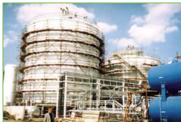
Фото 2. Резервуары с плоским днищем компании «Chart Ferox» для жидкого кислорода с объёмом 1800 м 3 и азота — 2200 м 3 в строительных лесах во время их окраски после сборки на месте
