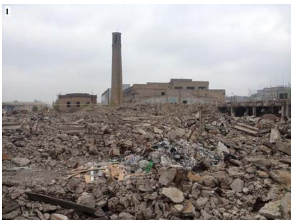
Рис. 2. Вид электролизного цеха (фото – Панаит Э. В., 2014 г.)
