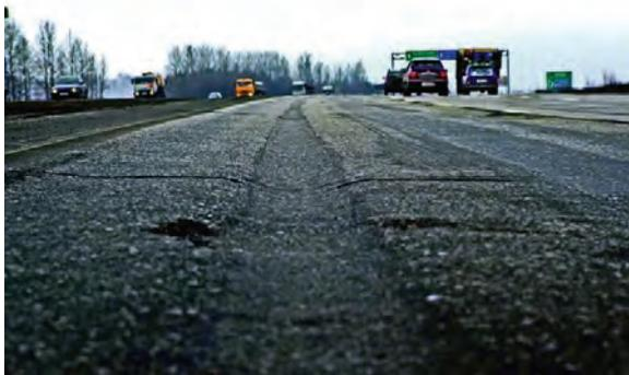
Рис.3. Колея на асфальтобетоне
