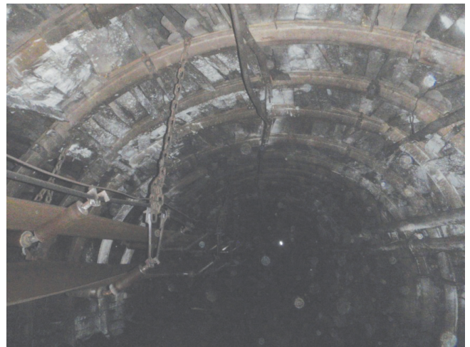
Рис. 4. Конвейерный штрек горизонта 980 м, закрепленный крепью КПДВ.
