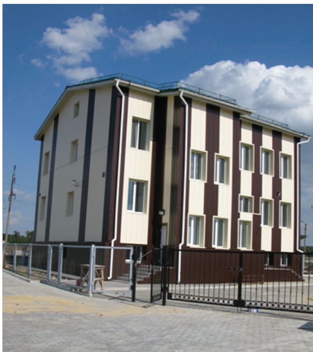
Рис. 1. Служебно-техническое здание сигнализации, централизации, блокировки и связи станции Транзитная.
