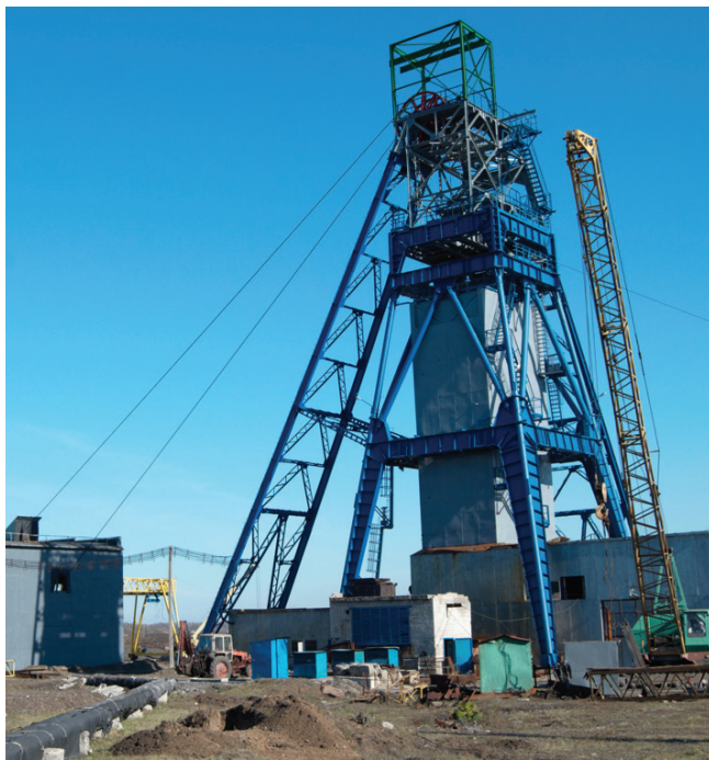
Рис. 1. Строительство комплекса вертикального воздухоподающего ствола шахты им. В. В. Вахрушева.
