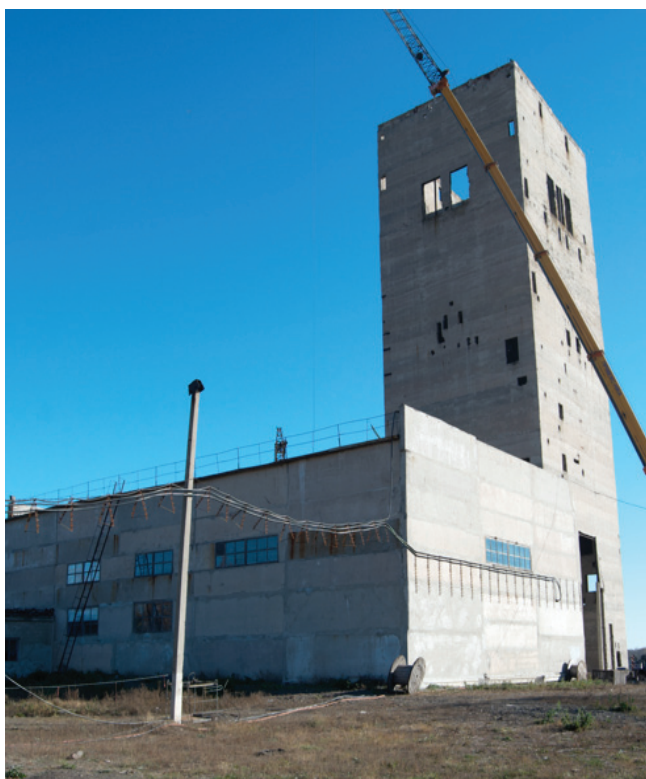
Рис. 2. Строительство комплекса южного вертикального воздухоподающего ствола шахты им. М. В. Фрунзе.
