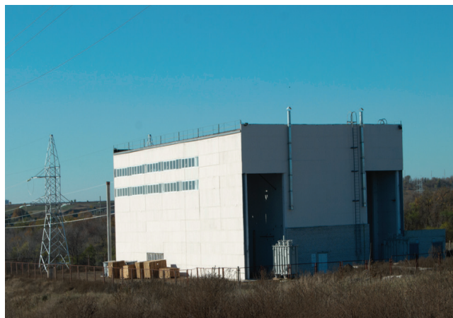
Рис. 3. Строительство подстанции ПС 110/6 кВ «Рафаиловка».
