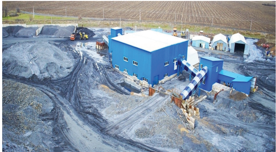
Рис. 2. Действующая модульная обогатительная фабрика компании «Монолит-Юкрейн» на переработке породного отвала.
