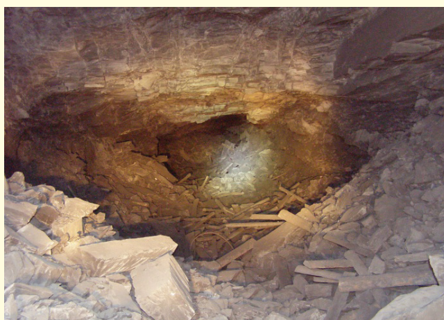
Рис. 4. Состояние выработок, расположенных в выработанном пространстве на шахте им. Я. М. Свердлова: а и б – бремсберга № 5 в центральной части 77-й западной лавы (Ф. 1) и на удалении 12 м (Ф. 2) от конвейерного штрека по истечении 26 мес после его проведения; в и г – бремсберга № 5 в центральной части 75-й западной лавы (Ф. 3) и на удалении 25 м (Ф. 4) от конвейерного штрека через 21 мес после его проведения; д и е – контуры остаточных сечений западного транспортного ходка перед извлечением крепи (Ф. 5) и после ее извлечения (Ф. 6).
