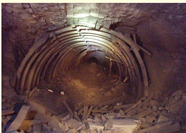
Рис. 4. Состояние выработок, расположенных в выработанном пространстве на шахте им. Я. М. Свердлова: а и б – бремсберга № 5 в центральной части 77-й западной лавы (Ф. 1) и на удалении 12 м (Ф. 2) от конвейерного штрека по истечении 26 мес после его проведения; в и г – бремсберга № 5 в центральной части 75-й западной лавы (Ф. 3) и на удалении 25 м (Ф. 4) от конвейерного штрека через 21 мес после его проведения; д и е – контуры остаточных сечений западного транспортного ходка перед извлечением крепи (Ф. 5) и после ее извлечения (Ф. 6).
