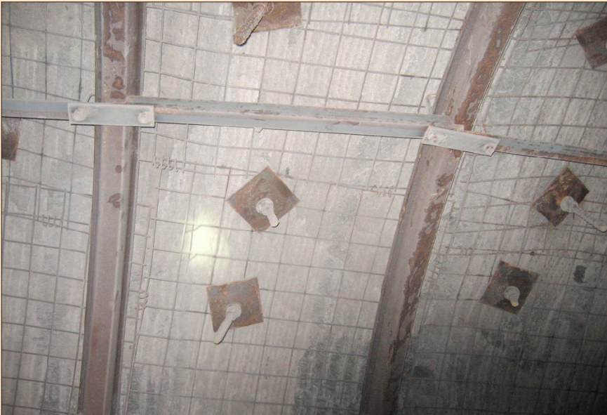
Рис. 1. Пример установки анкеров с наклоном в бортовом штреке № 520 на шахте «Терновская».
