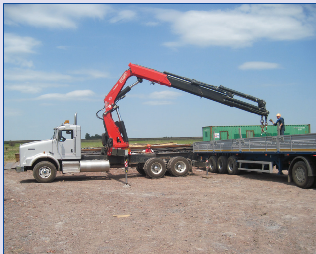
Рис. 4. Погрузочно-разгрузочные работы с использованием трейлера и автокрана.
