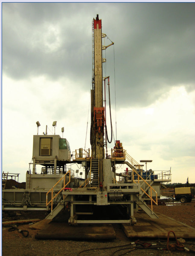
Рис. 3. Буровой комплекс, установленный на специальных деревянных настилах.
