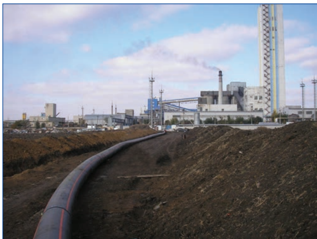
Рис. 1. Трубопровод перед спуском в траншею.
