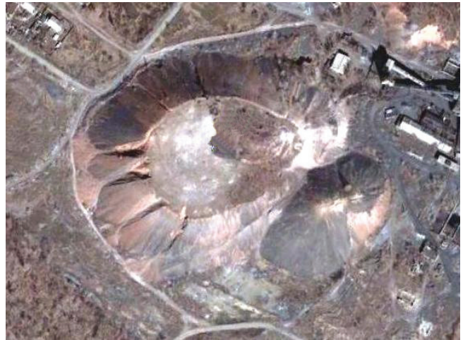
Рис. 1. Ерозійні та зсувні явища на поверхні породного відвалу зі зрізаною верхівкою.
