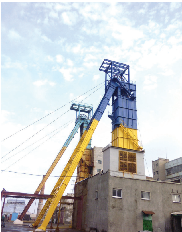
Копер металлический главного и вспомогательного стволов (шахта «Дуванная» ПАО «Краснодонуголь»).
