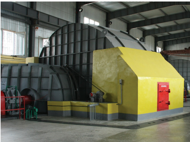
Вентиляторная установка главного проветривания ВЦД-31,5.
