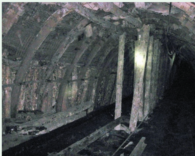
Рис. 5. Состояние выработки на расстоянии 80 м за лавой.
