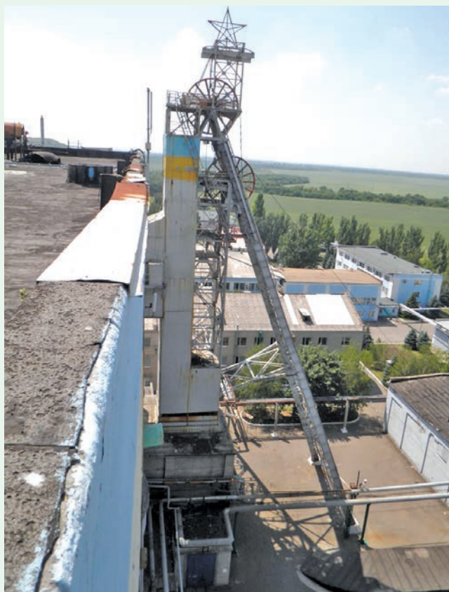
Рис. 2. Металлический копер вентиляционного ствола (горизонт 210 м).
