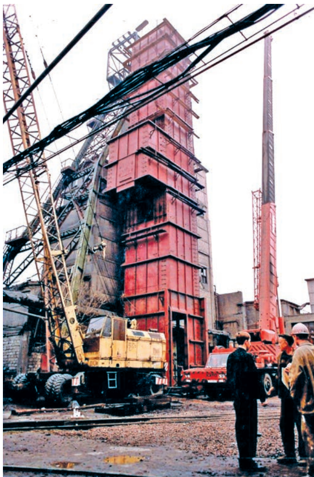
Замена копра скипового ствола блока № 1 (сентябрь 2001 г.).
