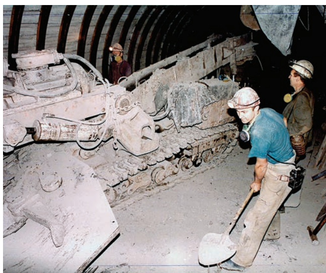
Проходческая бригада С. Кириллина проходит сбойку подземных выработок блока № 2 с блоком № 1 на горизонте 300 м.
