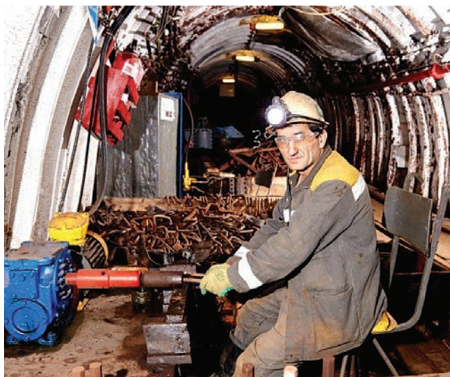
Восстановление элементов арочной крепи в подземной камере правки.
