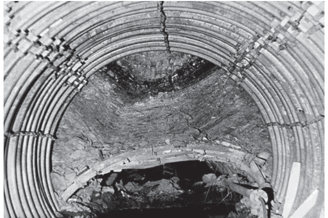
Рис. 6. Клинья выдавливания пород кровли в шахте «Западно-Донбасская».
