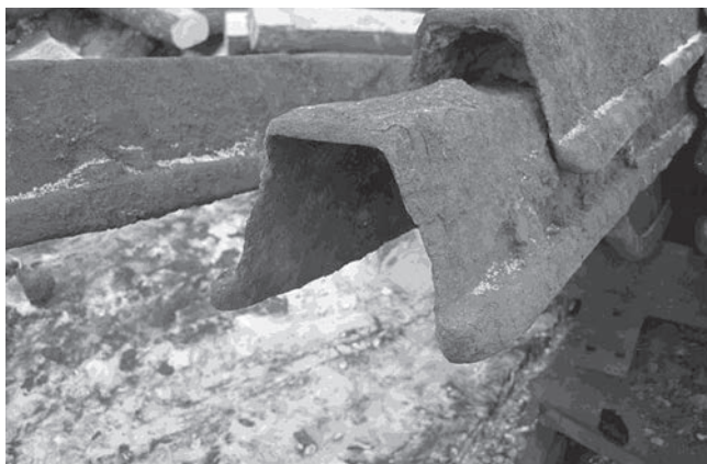
Рис. 10. Самозатягивание концов стоек арочной крепи при опускании их в породе подошвы выработки (шахта «Свято-Андреевская»).
