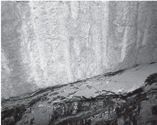
Рис. 4. Псевдоупучение угля (пласт l_2 ) из-под песчаника во 2-м южном конвейерном штреке шахты «Алмазная».
