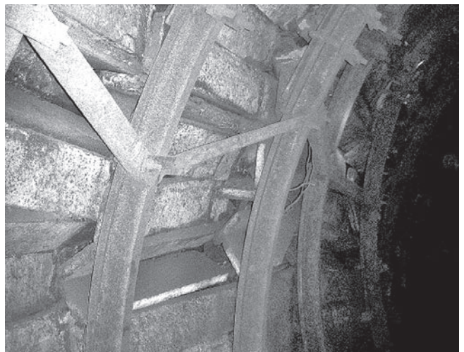
Рис. 8. Складывание затяжки в гармошку (шахта «Комсомолец Донбасса»).
