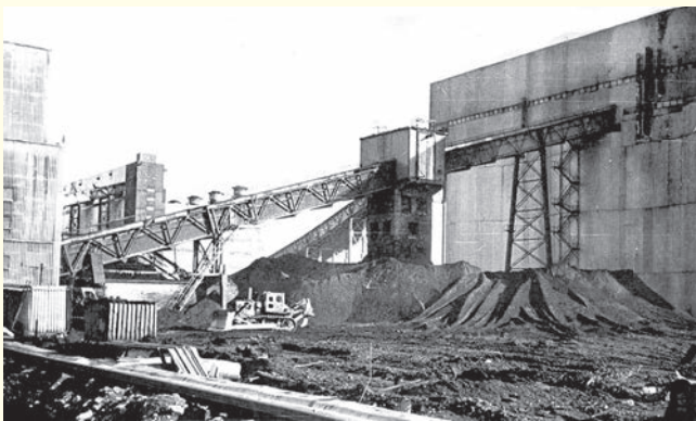
Рис. 1. Открытый склад энергетических углей разреза «Нерюнгринский» с разгрузочной колонной.
