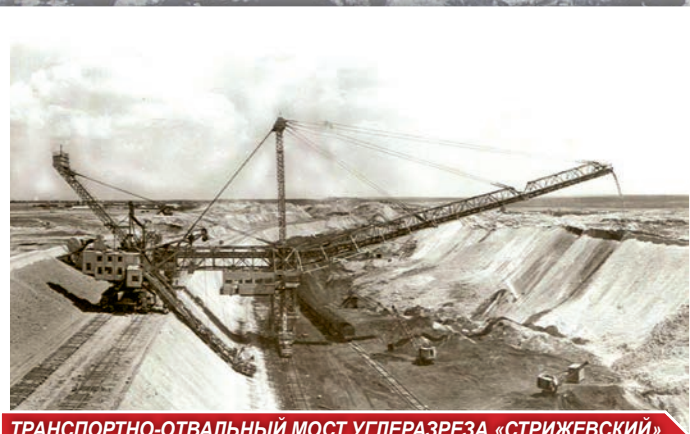
ТРАНСПОРТНО-ОТВАЛЬНЫЙ МОСТ УГЛЕРАЗРЕЗА «СТРИЖЕВСКИЙ»
