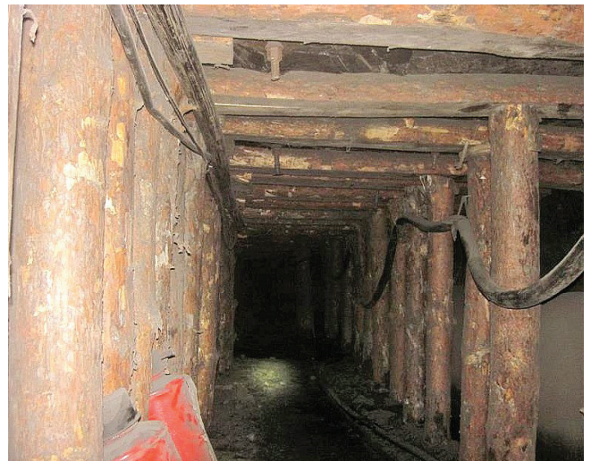
Рис. 5. Состояние 1012-й монтажной камеры.
