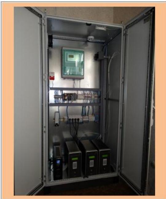
Каждый пост представляет собой программно-технический комплекс с процессорным модулем контроллера, модулем ввода/вывода сигналов, повторителем
