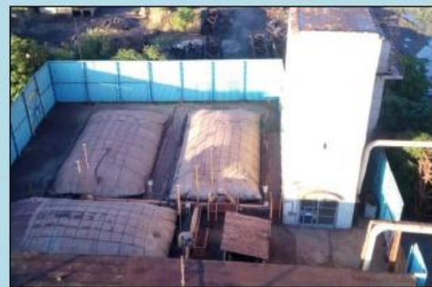
Рис. 3 Схема (а) и внешний вид (б) установки стабилизации давления коксового газа
