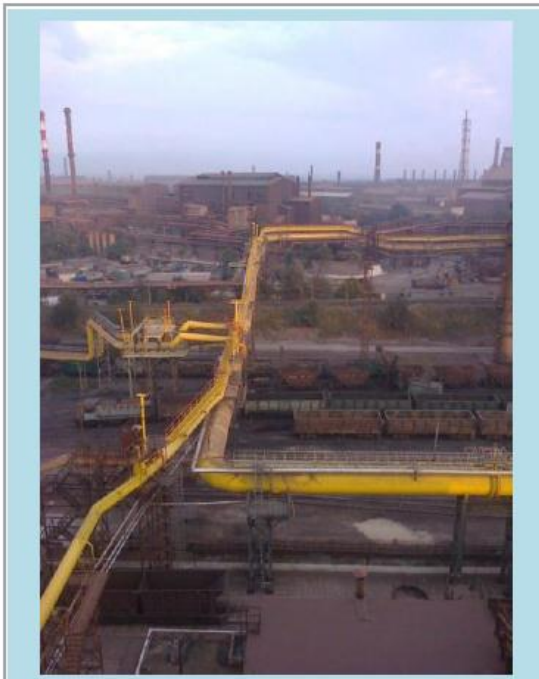
Рис. 1 Общий вид магистрального трубопровода
