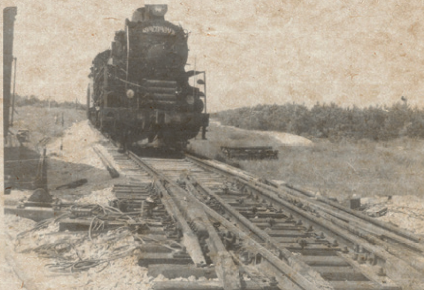
Випробування паровоза ФД № 18-224 типу І-5-2 на суміщеному стрілочному переводі з дерев'яними брусами
