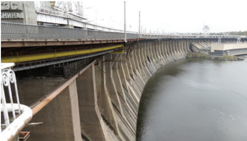
Випробування автопроїзду, автодорожніх переходів та аванкамери автодорожнього переходу Дніпровської ГЕС (м. Запоріжжя)
