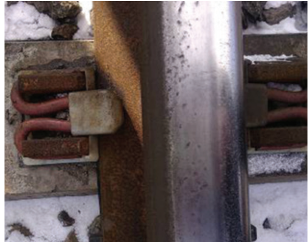
Скрепление типа Pandrol FASTCLIP FE.
