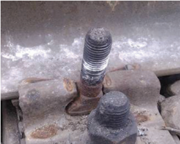
Клеммный болт БКС
