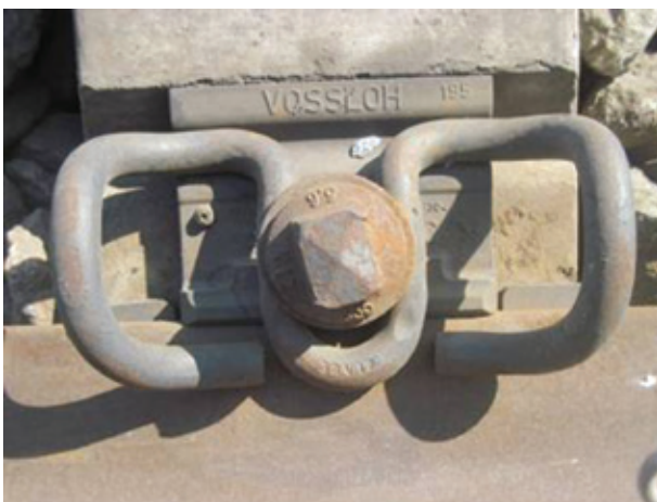
Скрепление системы W-30
