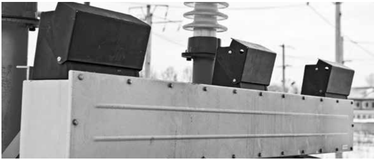
Рис. 2. Пристрій стеження за параметрами контактної мережі типу УСП КП
