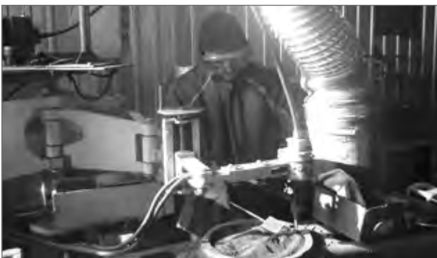
Рис. 14. Реновация надрессорной балки грузового вагона в ремонтном вагонном депо Знаменка
