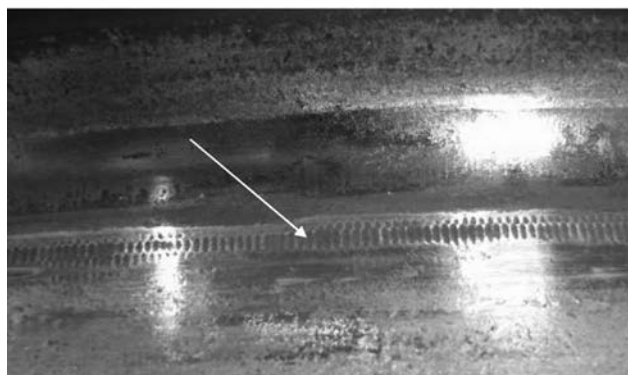
Рис. 9. Поражение поверхности катания колеса электрическим током (рифление)
