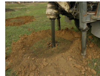
Рис. 1– Скважины под электроды повышенной проводимости растеканию
