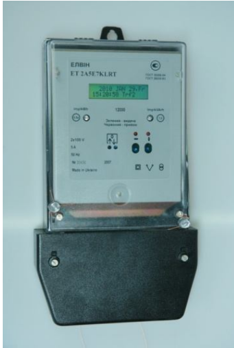
Рис. 3— Счетчик трехфазный электронный многофункциональный типа «ЕТ»
