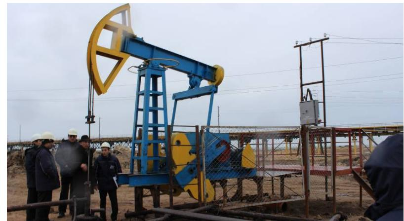
Рисунок 3 – Установка и пуск станка качалки СКД 3-1,5-710 с трехступенчатым двухпоточным пакетным редуктором с  $U_{\Sigma}=64$ , на промысле Пираллахи
