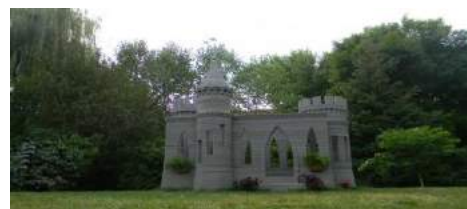
Фото 4. Замість будівництва - 3D друк з бетону
