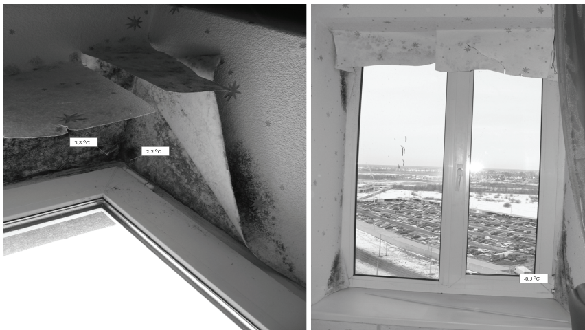
Рисунок 1 – Приклади конструктивних помилок вибору віконних конструкцій за тепловологісними параметрами.
