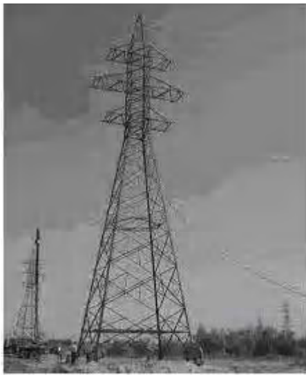
Рисунок 2 – Общий вид оптимизированной опоры У110-2+14.
