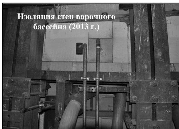
Рисунок 4 – Изоляция стен варочного бассейна в 2013 г.
