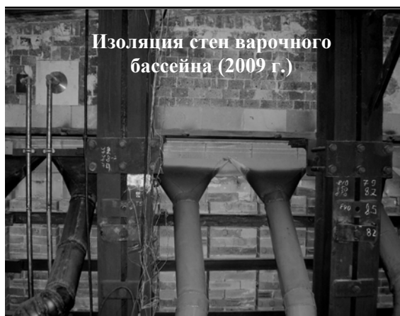
Рисунок 3 – Изоляция стен варочного бассейна в 2009 г.
