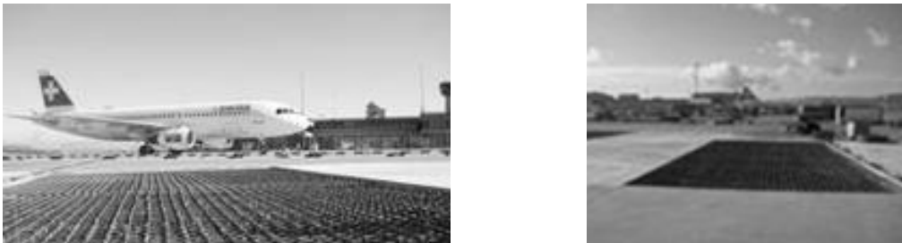
Рисунок 3 – Применение стеклопластиковой арматуры в дорожном покрытии.
