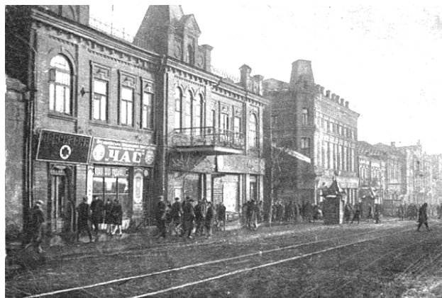
Рисунок 3 – Общий вид здания гостиницы «Гранд-отель» в начале 30-х годов.
